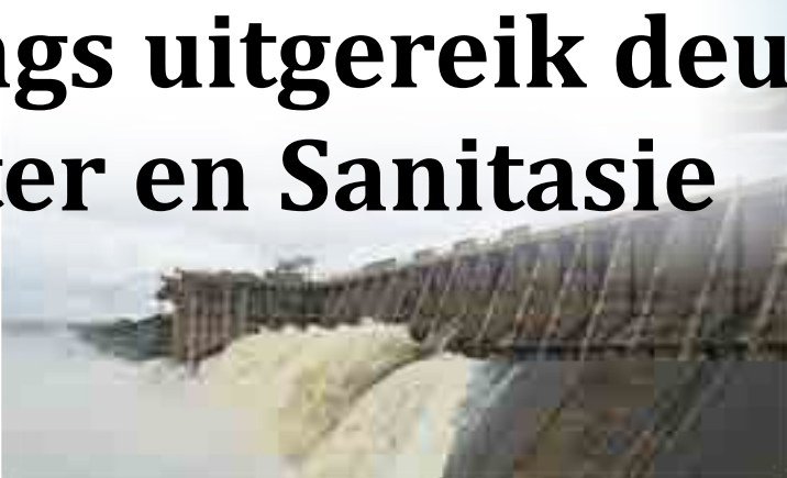
Foto bo: Vaal dam - twee van die tien sluise moes met tye gesluit word om uitvloei na laerliggende gedeeltes stroomaf van die dam te beheer.
