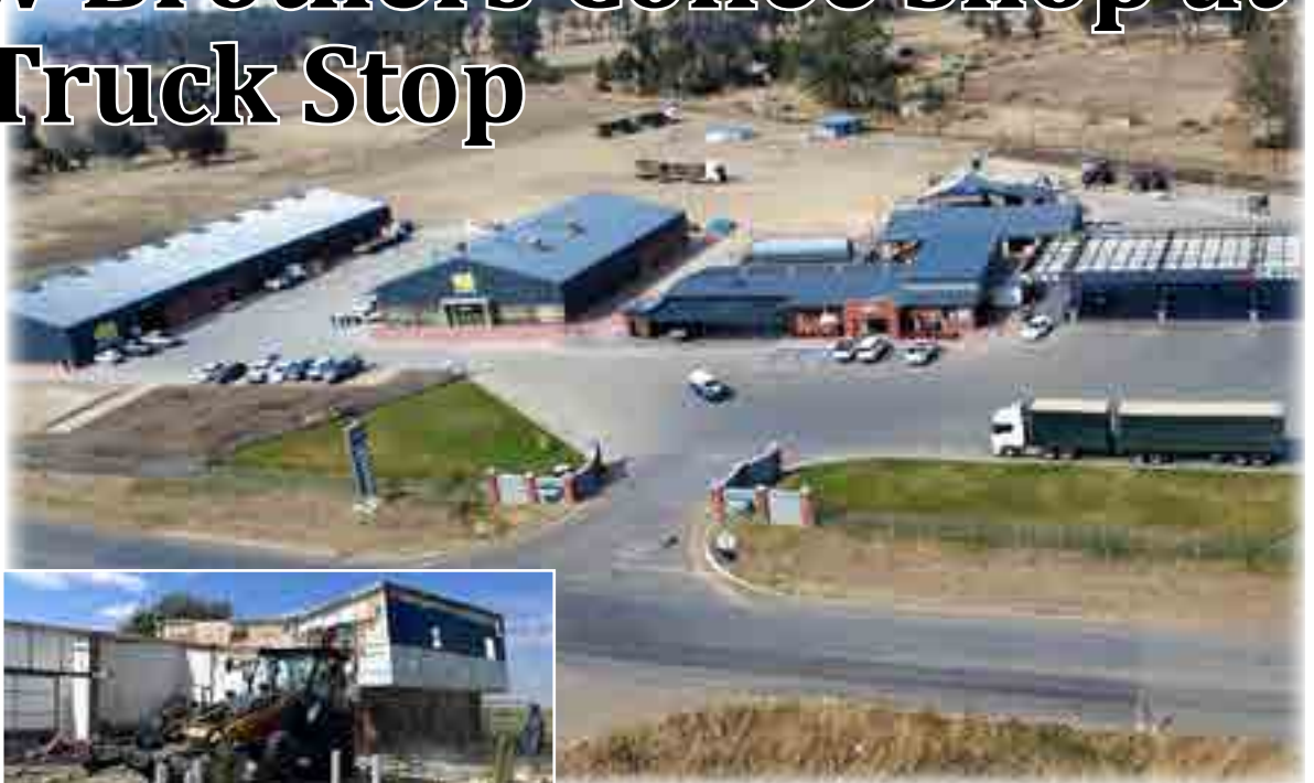
Op die foto links: Voorheen Stop Inn gebou wat gesloop is. Foto bo: Nuwe VKB kompleks en Iceberg Truck Stop.
