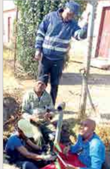
Munisipale werkers probeer om 'n ou munisipale boorgate te red om nog waterpunte beskikbaar te stel vir inwoners. Die boorgate staan deels op 'n sypaadjie. Met ter perse gaan was dit nog onduidelik of dit in gebruik geneem is!
